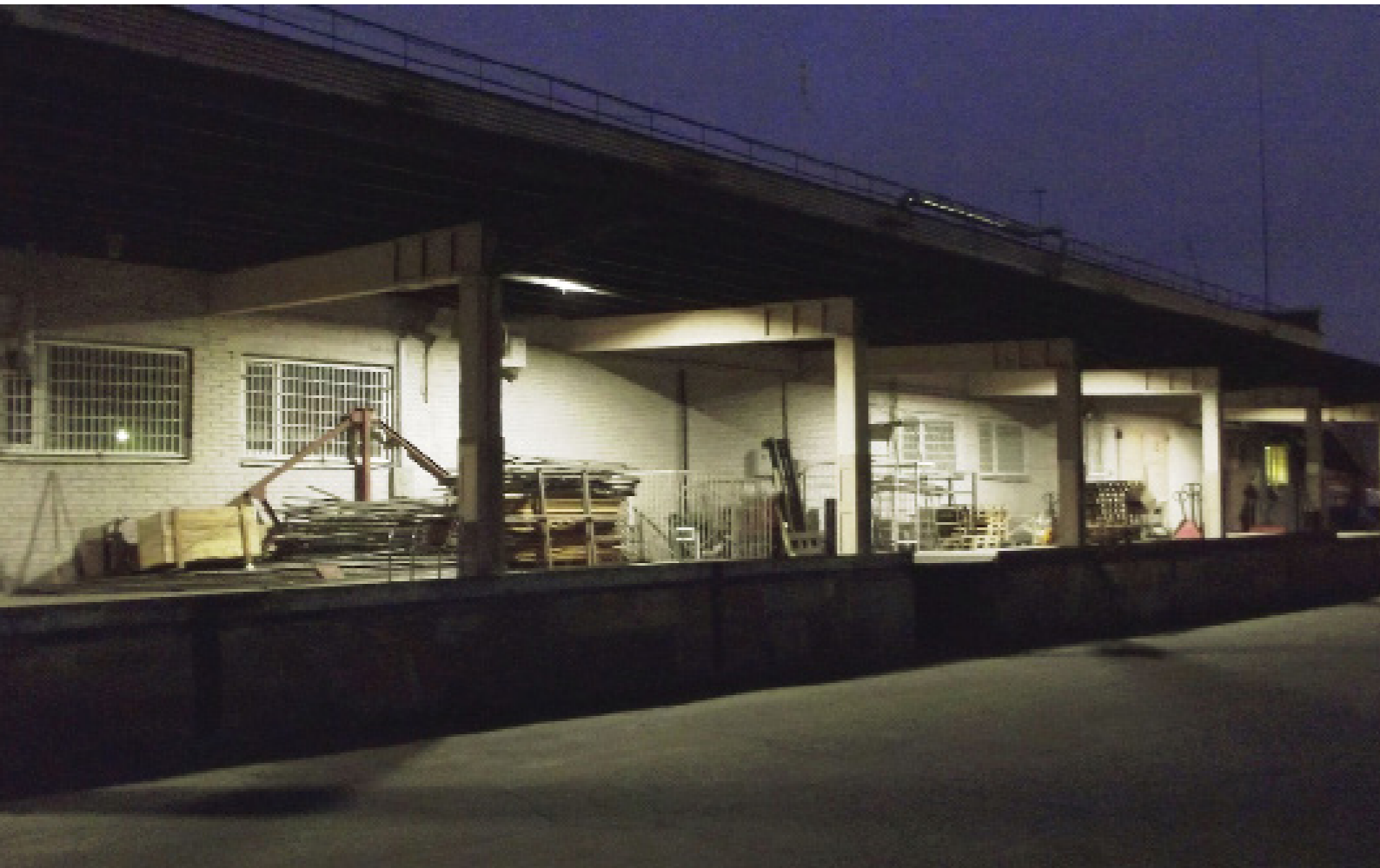
Освещение светильниками серии TUNNEL
