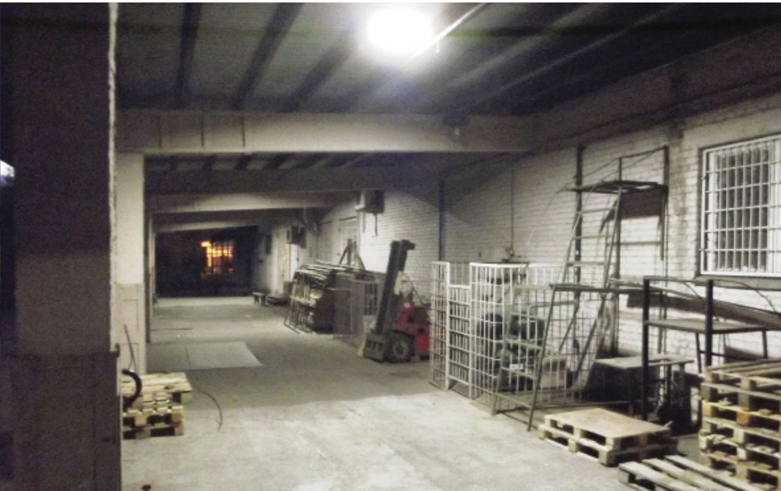
Освещение светильниками серии TUNNEL
